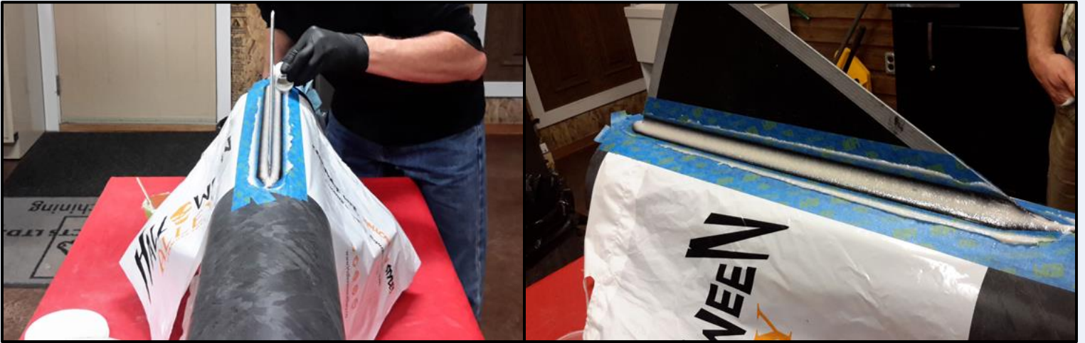
Fabrication de filets externes avec de l'époxy 'West System' et de la silice colloïdale pour créer un agent de remplissage ayant la même consistance que le beurre d'arachide.
